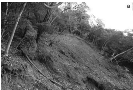
写真-2 a 八木六丁目の崩壊源頭部，付加体の混在岩が露出する。一部で斑状流紋岩岩脈も露出する。
