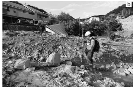
写真-3b 複数回の土石流が到達した痕跡が残る堆積部。
