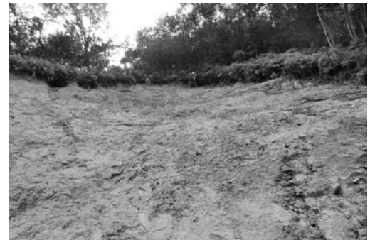
写真-5 林道沿いで発生した細粒花崗岩の表層崩壊。
