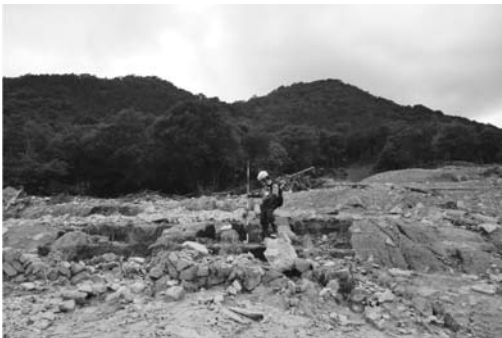
写真-4 ゴルフ場での堆積部(マサ土)。土層厚は50cm程度。
