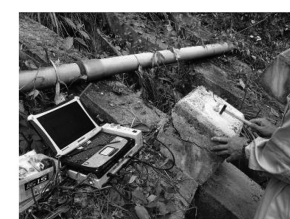
グラウンドアンカー健全性調査状況
