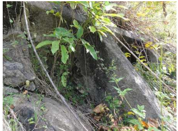
図 3.1.10 縦枠背後の空洞及び背後地盤の 状況
