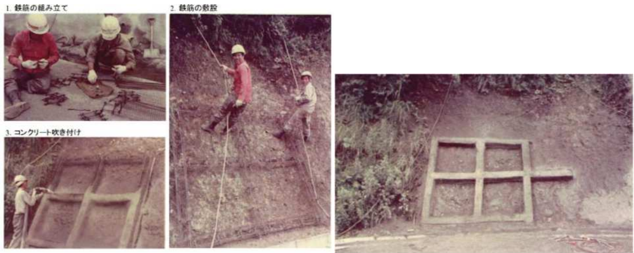
(a) 施工状況
