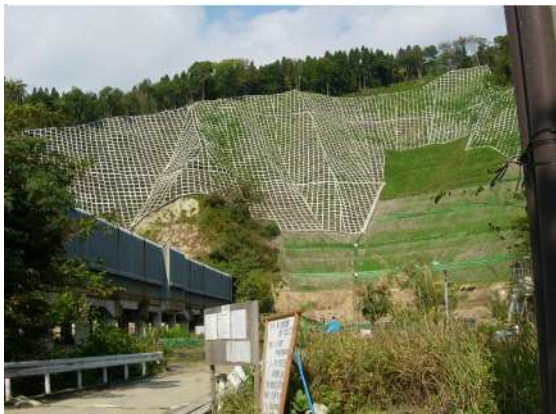
(a)施工直後状況(2006.10.24)
