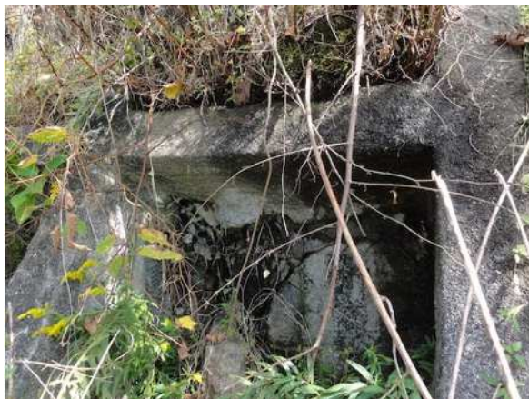
図 3.1.11 背後地盤の状況
