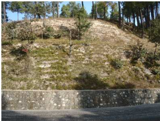
図 4.2.2 風化の進んだ基岩切土法面の保護対策(段切と緑化、法面脚部に側溝を設けている)
