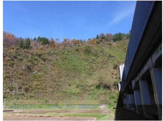
(b)施工後 13 年後状況(2019.11.24)
