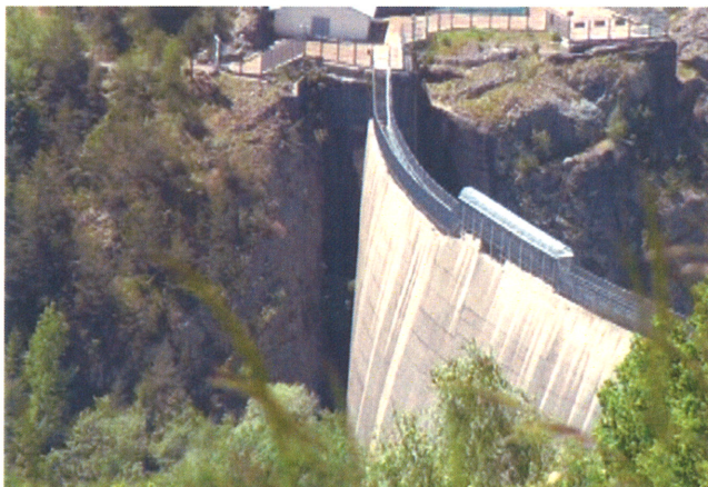
バイオントダムの上流面を右岸から望む
