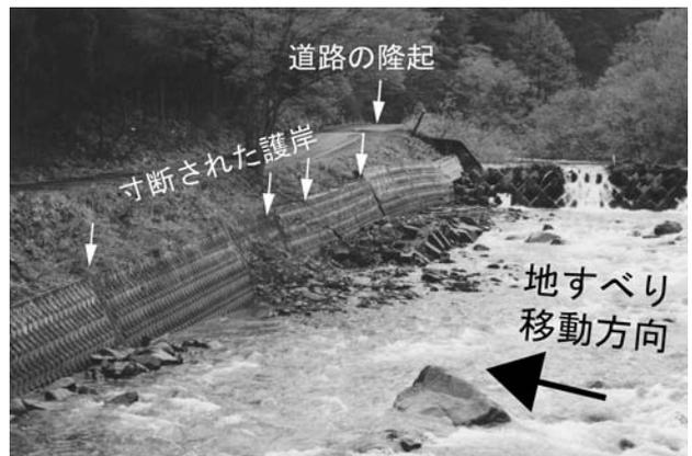
写真-7 川底を通して対岸に隆起したすべり面。
