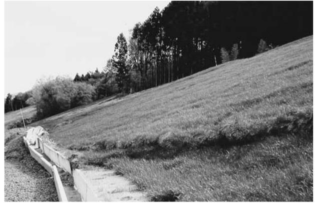
写真-5 土塊のせり出しと圧縮亀裂（地すべり末端部）
