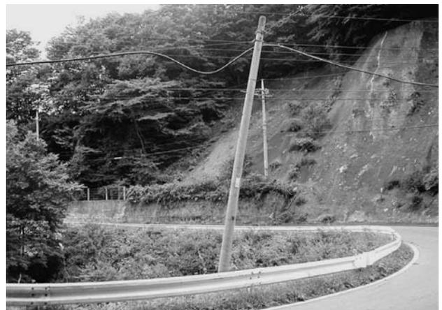
写真-14 地すべり滑動で傾斜した電柱
