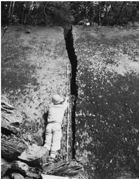
写真-9 擁壁のズレ亀裂（地すべり側部）
