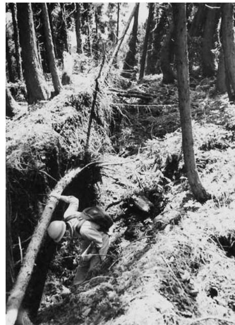
写真-23 地すべりブロック内のクラックと根の切断や引っ張り状況
