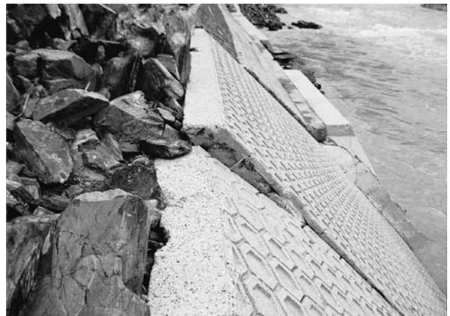
写真-6 擁壁の起き上がり（地すべり末端部）
