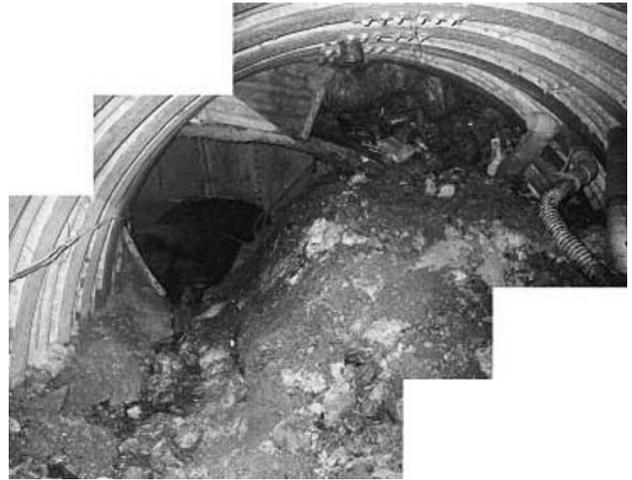
写真-13 地すべり滑動で変形した排水トンネル工とボーリング室に溢れ出た地すべり土塊の一部
