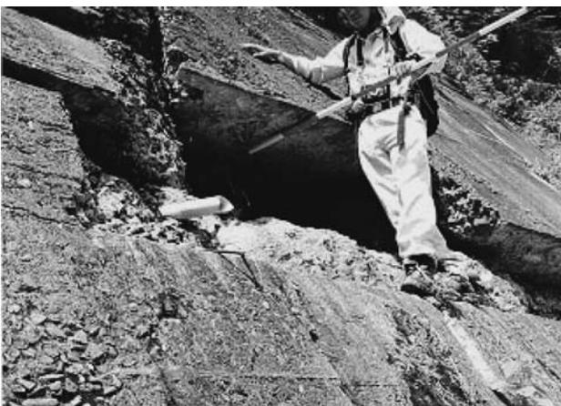
写真-3 擁壁の水平亀裂（地すべり頭部）
