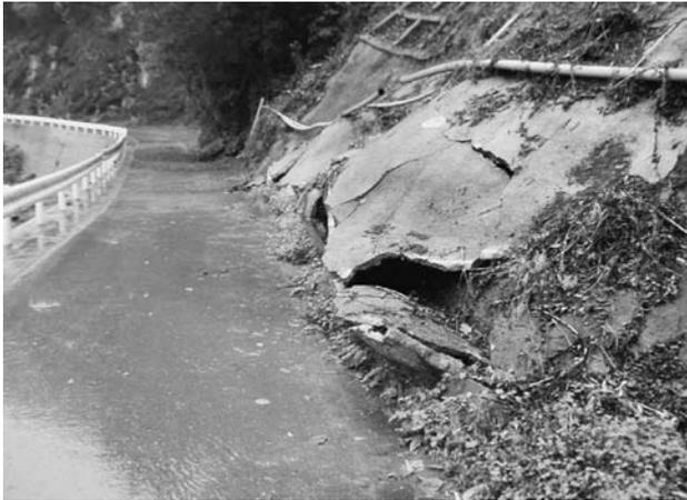
写真-7 モルタル吹付け部のせり出しと法尻の隆起（地すべり末端部）
