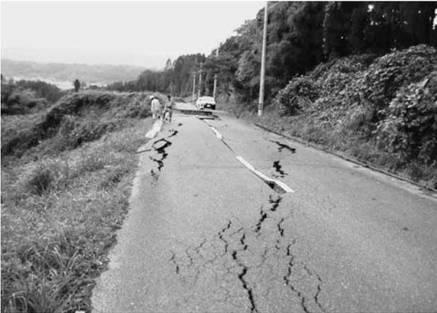
写真-2 道路縦断方向に伸びる開口亀裂（地すべり頭部）
