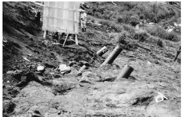
写真-10 斜面下方に傾動した鋼管杭
