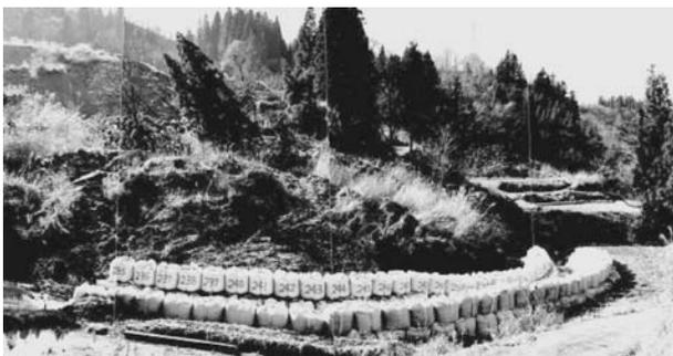
写真-4 地すべり末端部の河川護岸として大型土のうを用いた例
