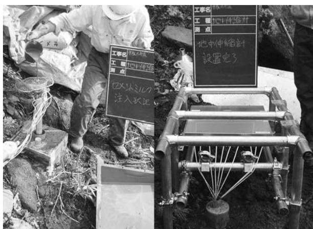
写真7 測定不能後の孔内傾斜計内に設置した多層移動量計の事例
