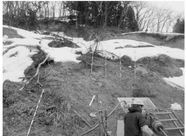
写真二 応急横ボーリング工の施工状況
