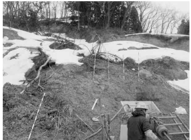
写真－２ 応急横ボーリング工の施工状況
