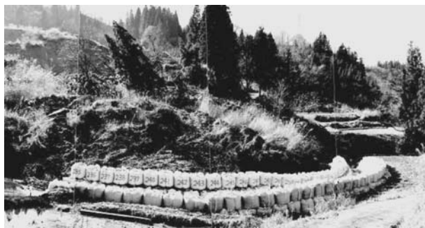
写真-4 地すべり末端部の河川護岸として大型土のうを用いた例
