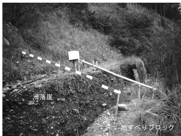
写真－6 実移動量と差が生じる地表伸縮計設置例
