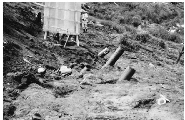
写真-10 斜面下方に傾動した鋼管杭
