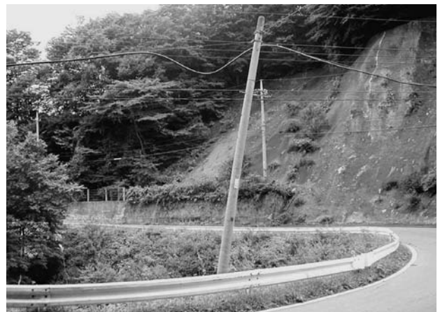
写真-14 地すべり滑動で傾斜した電柱
