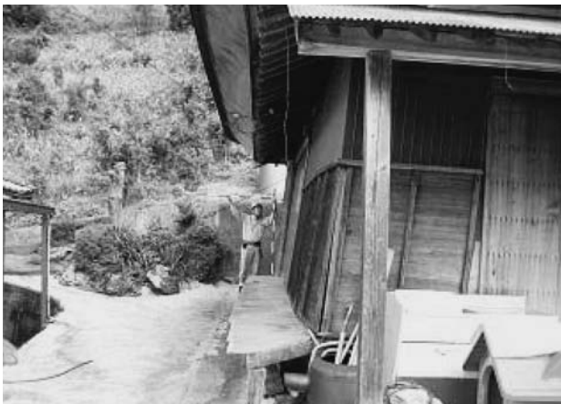
写真－４ 傾斜した家屋（地すべり頭部）
