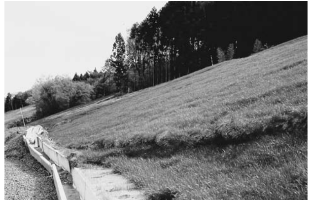
写真－５ 土塊のせり出しと圧縮亀裂（地すべり末端部）
