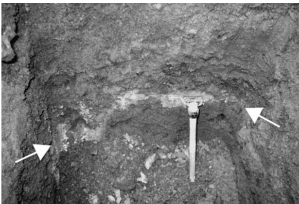
写真一 8 地すべり末端部のバックホー掘削で確認されたすべり面。すべり面は白色の凝灰岩質な粘土（秋田県島海町）
