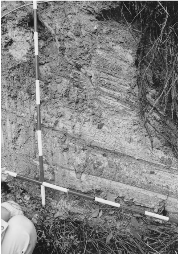
写真-3 地すべり側崖に見られるすべり痕跡（擦痕） 壁面に見られる擦痕の傾斜はすべり面の傾斜とほぼ同じもの と思われる（福島県いわき市）
