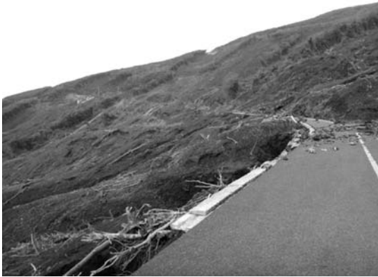
写真-8 大金沢を横断する道路の状況
