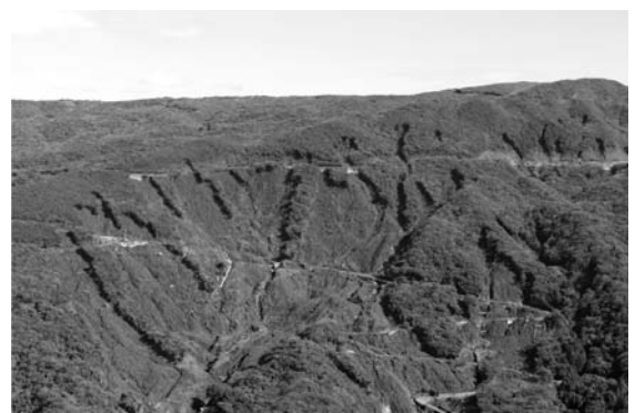
写真-7 大金沢の表層崩壊（写真提供：林野庁）
