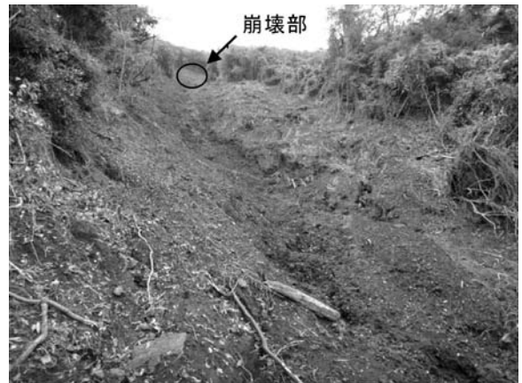
写真-5 表層崩壊地の流送部の状況
