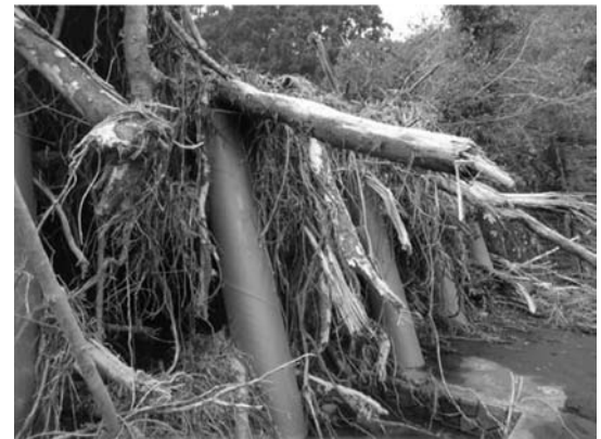
写真-11 流木を捕捉したスリットダム
