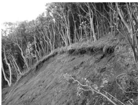
写真-3 表層崩壊地の頭部（遷急線付近から崩壊）
