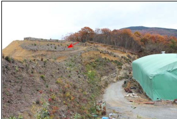
写真 2 上釜戸地すべりの頭部
