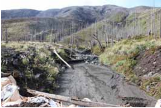
写真 2-5 溪流部の荒廃状況
