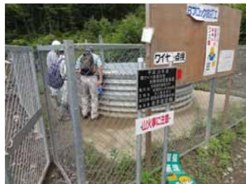
写真 1-2 集水井の設置状況
