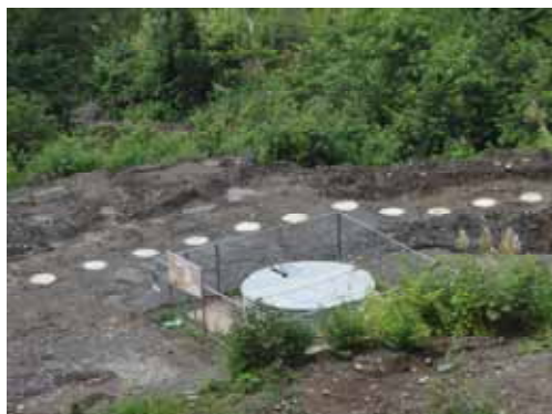
写真 1-3 杭工と集水井配置
