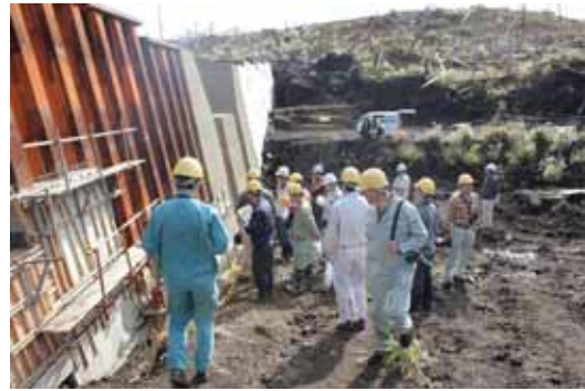
写真 2-6 ダブルウォールの砂防ダム
