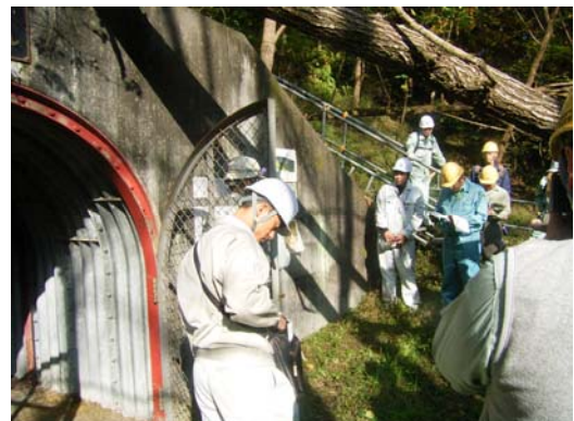
写真 2-2 排水トンネル状況
