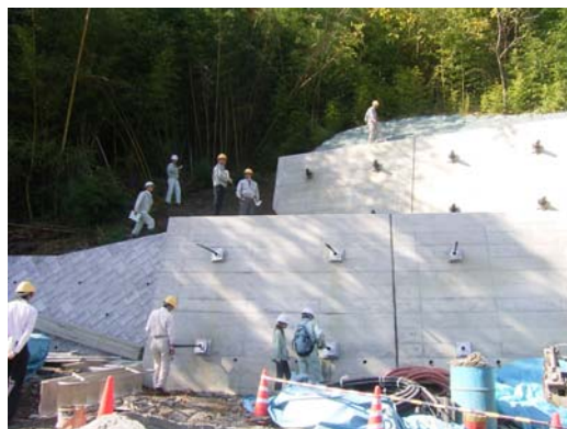
写真 2-4 アンカー施工状況
