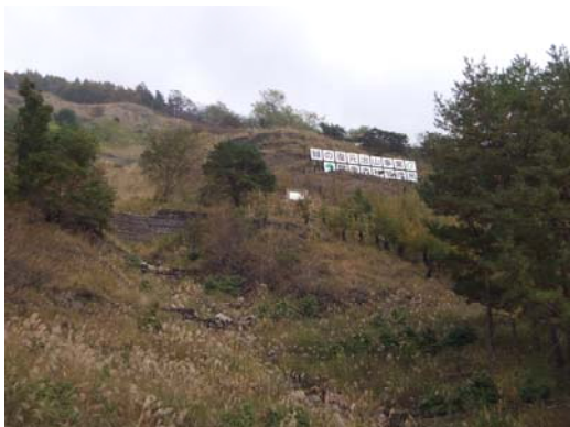
写真 1-3 山腹斜面状況
