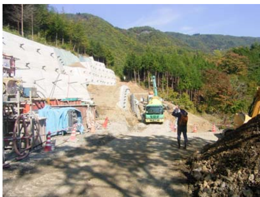
写真 2-3 アンカー施工状況
