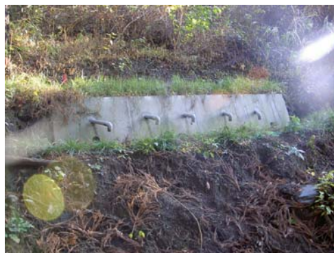
写真 2-3 滑落崖付近の水抜き工
