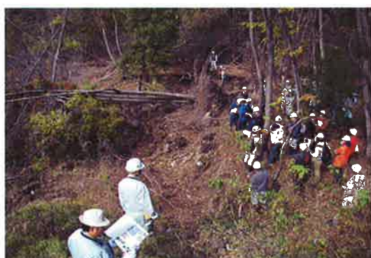
写真 9 滑落崖付近の状況
