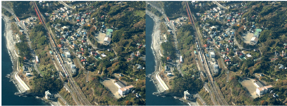
写真－1 根府川駅地すべりの空撮写真（立体視ペア写真，平行法）
