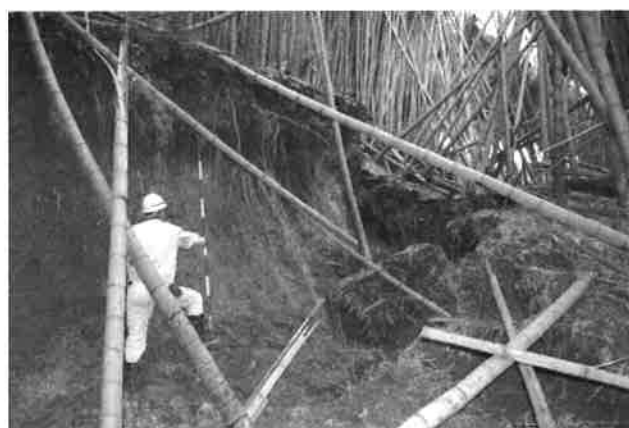
写真-3 地すべり地内の段差の状況
