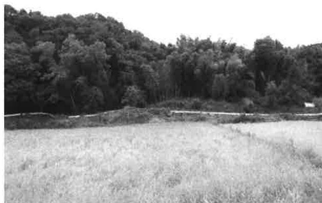
写真-2 末端部の状況
