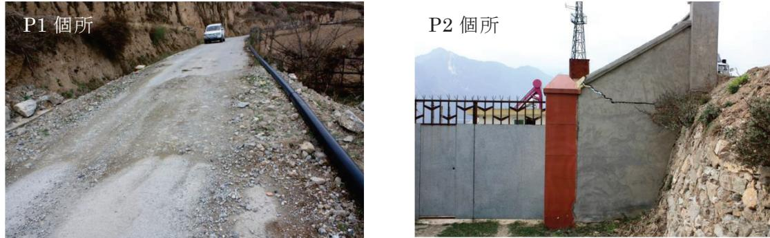
図2.30 地すべりによる地盤変動が現れた個所
