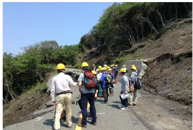
写真-3 崩壊発生箇所の視察状況
