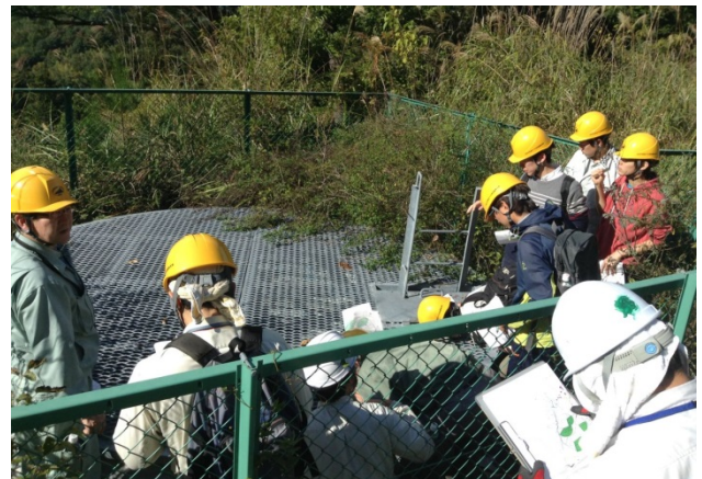
写真-2 集水井工の視察状況
