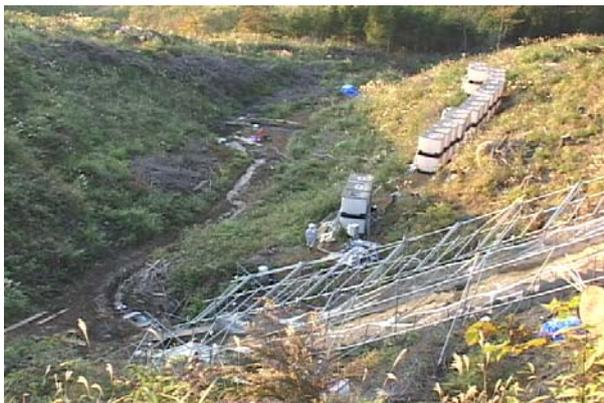
図-6 崩壊土砂の流下状況
