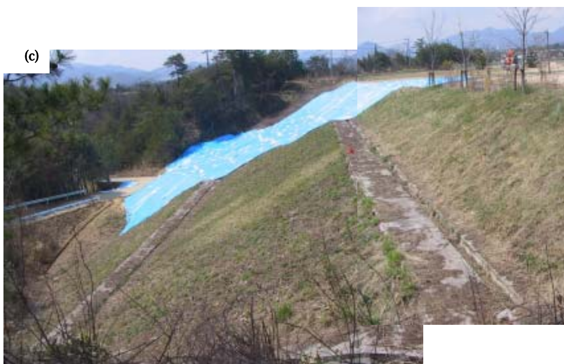
写真3 広島大学本部キャンパス南端の流動性崩壊 . (a)(b) 発生直後の源頭部と末端からの写真 (CHUKEN 社撮影) , (c) 崩壊全景 .
