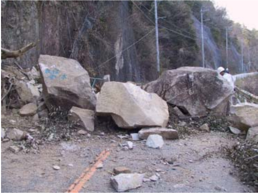
写真6 賀茂郡河内町下河内の棕梨川上流一般国道432号沿いで見られた落石。
