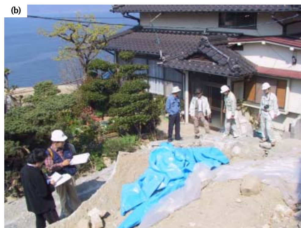
写真1 呉市的場町・越智方擁壁の崩壊．(a)擁壁下方からの写真，(b) 擁壁上からの写真．
