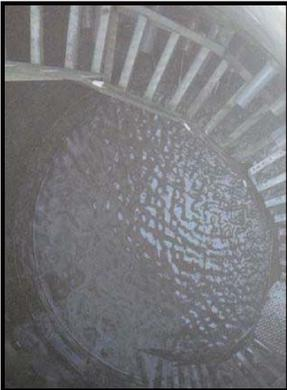
写真1 Aブロック内の集水井工の湛水状況
