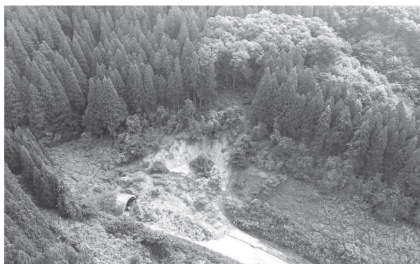
▲写真2 県道トンネル坑口の切土のり面崩壊
