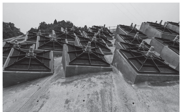
▲写真2 アンカー工施工状況
