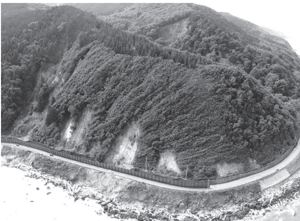
▲写真1 焼山崎周辺における被災状況 (撮影日:2021.9.20;撮影者:山本佑介)
