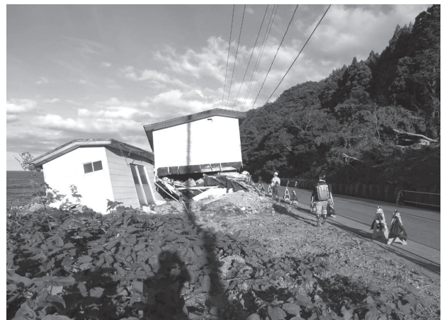
▲写真2 人家の被災状況
