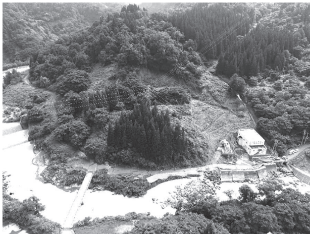
◀写真1 柳淵地すべり全景
