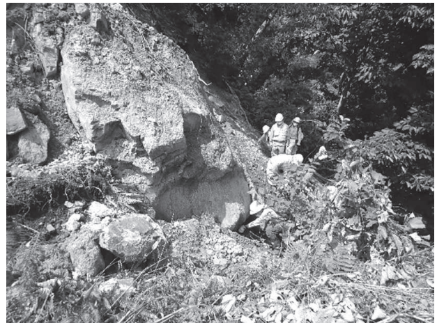
▲写真2 柳淵地すべりの滑落崖
