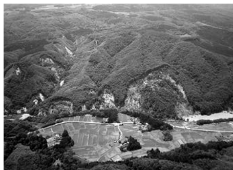
▲平成20年6月18日 井良沢道也撮影(岩手・宮城内陸地震直後)写真の上部背後に広がる磐井川地すべり事業実施区域は崩壊、地すべりがほとんど無し。未実施の市野々原地区で地すべりが発生した。
