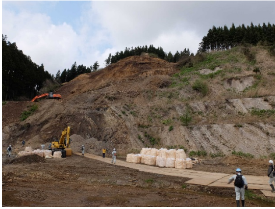
大内褶曲を見ることができる土取場
