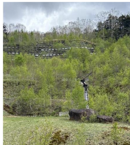
熊池ブロック対策工状況
