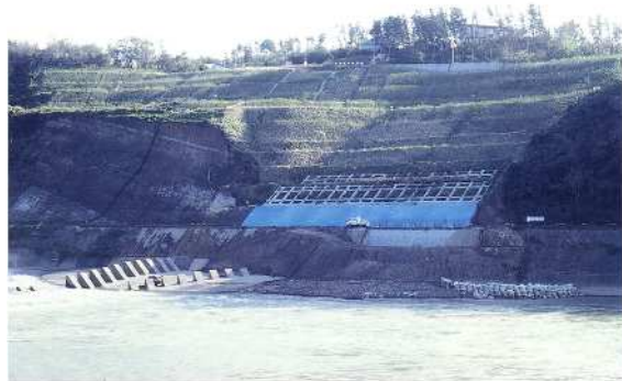
図6 9) 崩壊直後(地すべりの末端は法先に出ているように見えるが、途中で抜けている) 図7 対策工施工後
