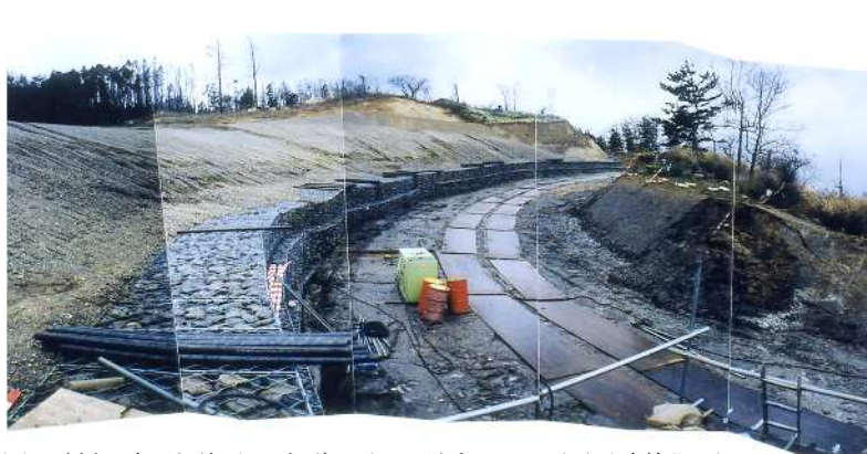
図 18(上) 路面を計画より上げることで、地すべりはようやく沈静化した
