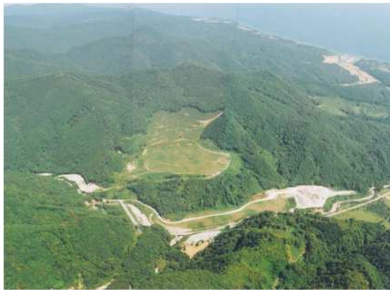
図 29 11) 復旧後の地すべり全景(被災の約7年後に撮影)
