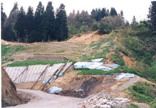
図11 1) 切土工事中に不安定化した斜面(新潟県川口町) 図12 1) 切土工事後、翌年の春先に発見された例(新潟県守門村)
