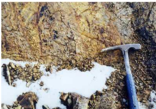
図13 切土整形直後の安定したのり面(泥岩層)
