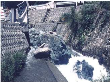
図 25 河床の隆起(すべり面か?), 左右の護岸工がほぼ接している(7/23)
