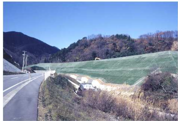
図 30 11) 右岸に移設された県道と改修された梅津川及び押え盛土工
