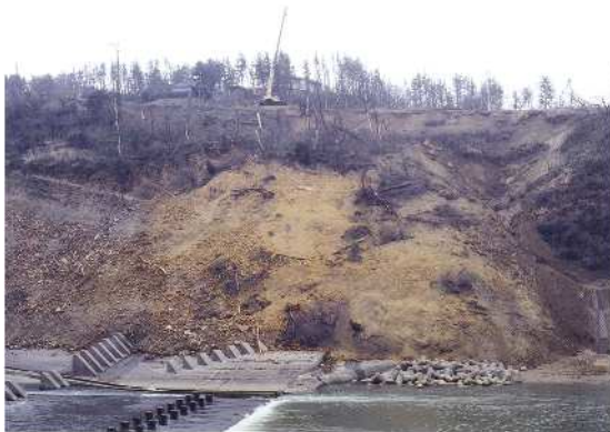
図6 9) 崩壊直後(地すべりの末端は法先に出ているように見えるが、途中で抜けている) 図7 対策工施工後
