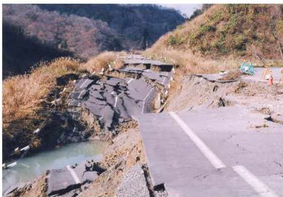
図8 9) 被災直後(沢を埋めて盛土した部分が崩壊している。場所:長岡市(旧小国町)法末) 図9 9) 復旧工事中(旧道を原付バイクが走っている)
