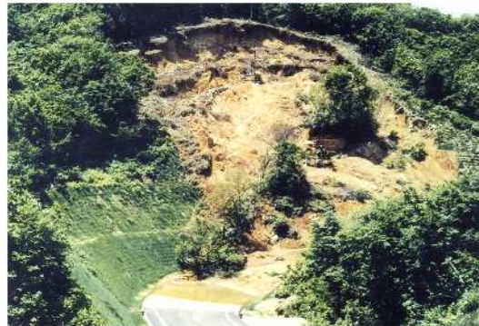
図11 1) 切土工事中に不安定化した斜面(新潟県川口町) 図12 1) 切土工事後、翌年の春先に発見された例(新潟県守門村)
