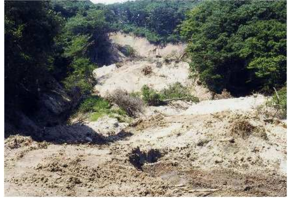
図10 土石流化して流れ下った地すべり(新潟県佐渡市)
