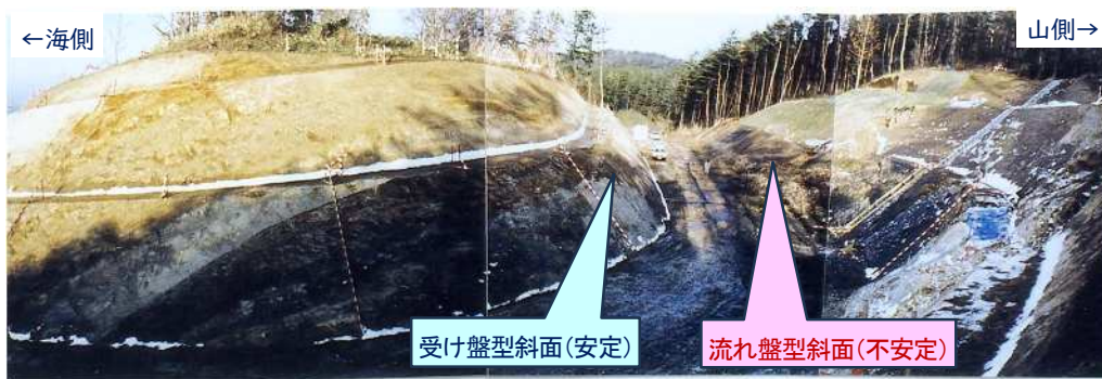
図 15 2) 流れ盤型、受け盤型の違いによる斜面の安定性の相違。地層は写真左側に向かって傾斜、右の流れ盤斜面で崩壊が発生
