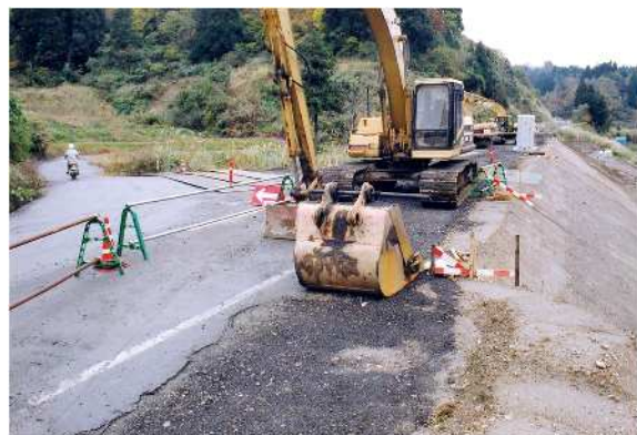
図8 9) 被災直後(沢を埋めて盛土した部分が崩壊している。場所:長岡市(旧小国町)法末) 図9 9) 復旧工事中(旧道を原付バイクが走っている)
