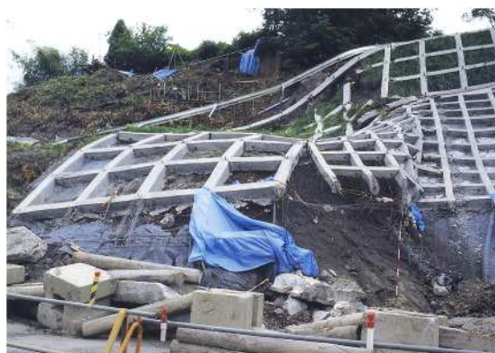
図4(左) 1) 切土斜面に対する当初の斜面対策工は練り積みブロック擁壁工+のり枠工であったが、そもそも両者とも崩積土には適さない。図5(右) 斜面端の崩壊を免れた部分。切土のり面には礫混り土が見られ(黄色い楕円部分)、この斜面が崩積土からなることを示す。
