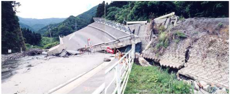
図 25 河床の隆起(すべり面か?), 左右の護岸工がほぼ接している(7/23)
