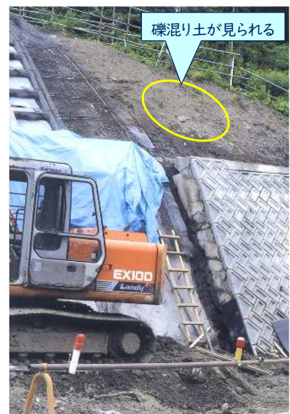
図4(左) 1) 切土斜面に対する当初の斜面対策工は練り積みブロック擁壁工+のり枠工であったが、そもそも両者とも崩積土には適さない。図5(右) 斜面端の崩壊を免れた部分。切土のり面には礫混り土が見られ(黄色い楕円部分)、この斜面が崩積土からなることを示す。
