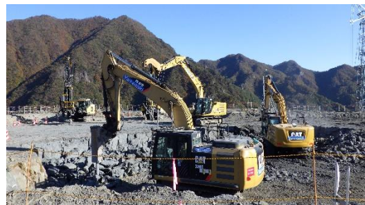
写真-2 北野牧工事 掘削工実施状況
