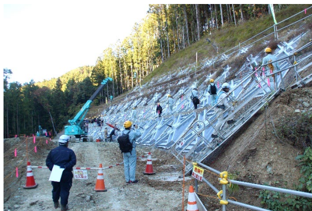
写真-2 施工中のアンカー工を見学
