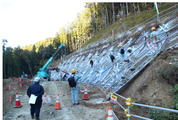
写真-2 施工中のアンカー工を見学
