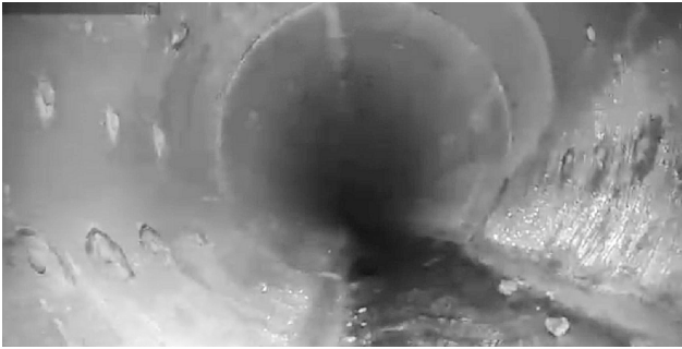
写真7 正常な暗渠管の内部 20) φ900mmのコンクリート有孔管
