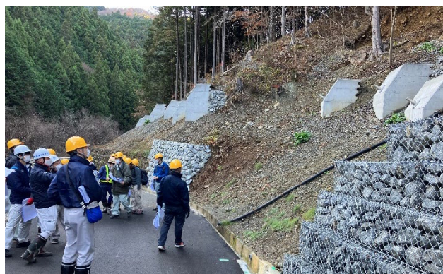
写真-2 抑止杭の頭部を緊張しているアンカー工
