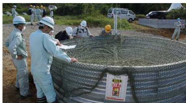
写真-2 対策工(集水井)見学状況
