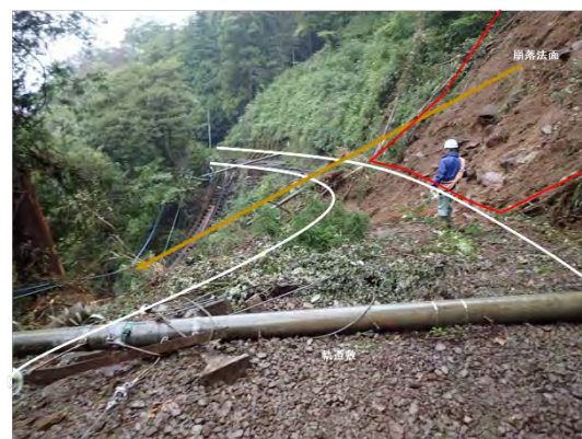
写真 3-2 崩壊地斜面下部の状況 (崩落土が鉄道の橋脚や線路を流失させた)
