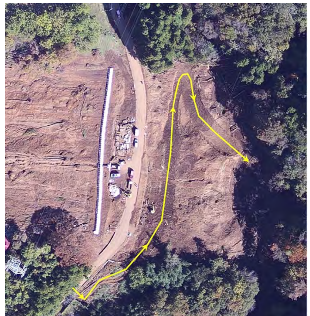
図10 重機の進入経路(相模原市消防局作成)
