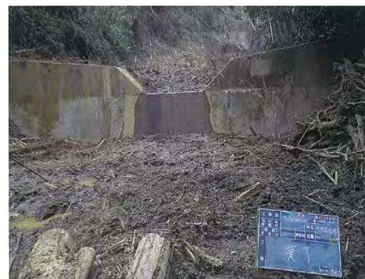
写真 5-2 治山施設に堆積した土砂等の撤去（施工後）
