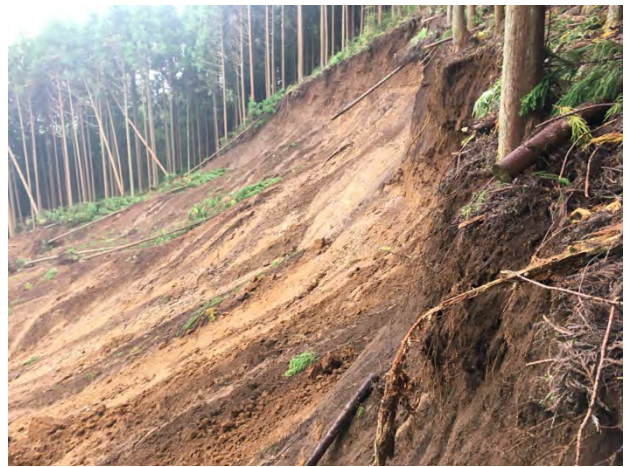
図5 源頭部の状況（10月14日12時頃）
