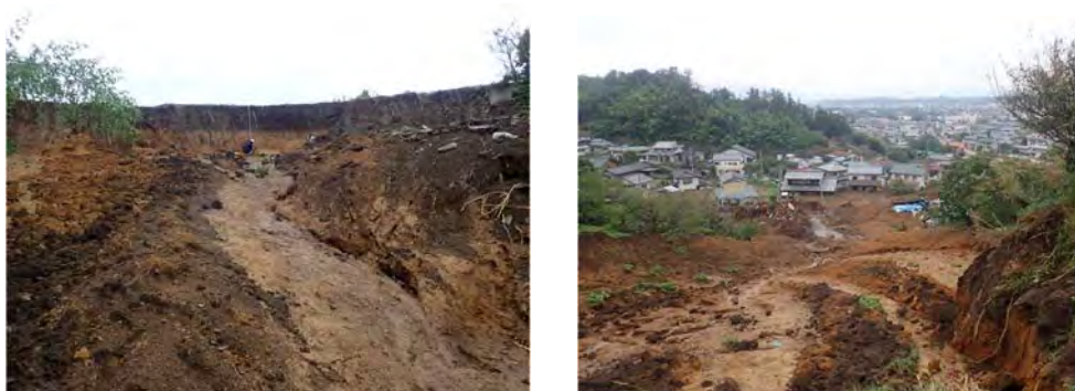
写真2 現場の状況写真.
