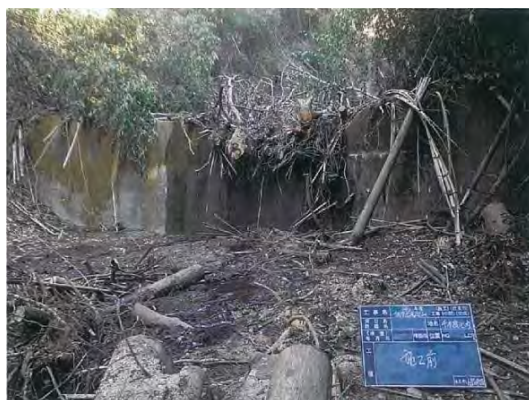
写真 5-1 相模原市緑区地内：(施工前)
