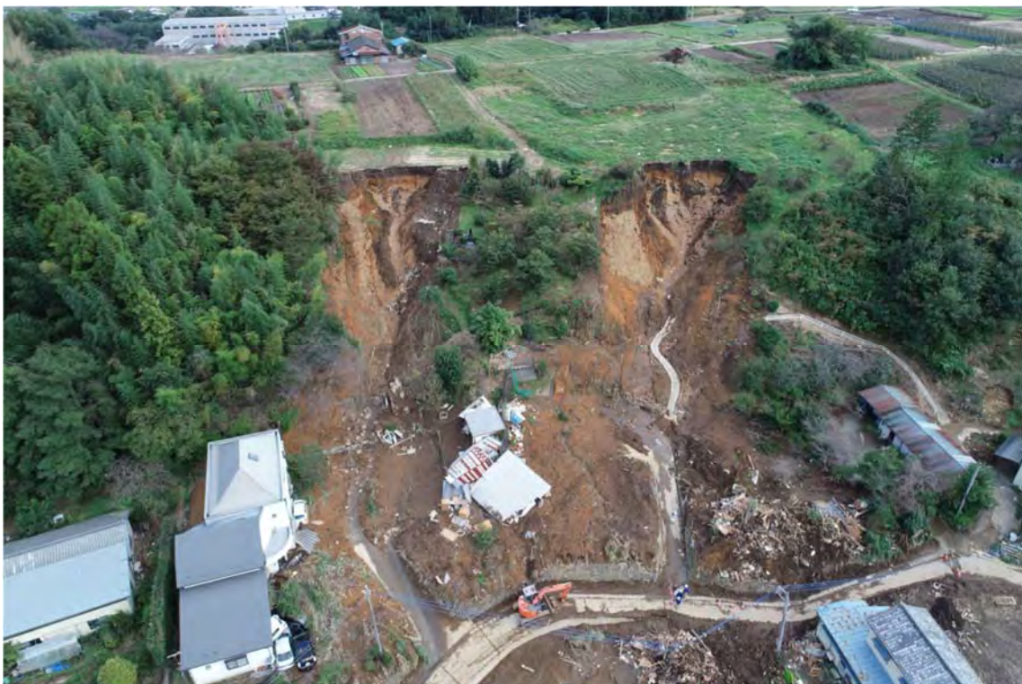
写真1 群馬県内匠地区の斜面崩壊。 提供：群馬県，日本サーベイ株式会社
