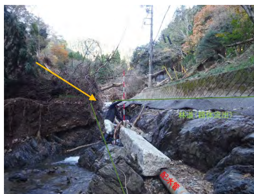
写真 1-2 崩壊地斜面下部の状況 （崩落土で河川が閉塞し林道路体を流出させた）
