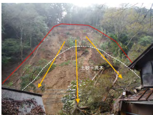
写真 1-1 崩壊地全景の状況
