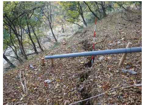
写真 2-1：頭部引張亀裂
