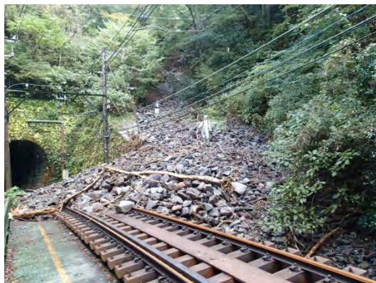
写真 4-1 鉄道の大沢橋梁付近の状況
