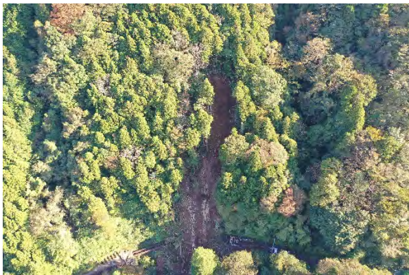
写真 3-1 上空からみた崩壊地の全景
