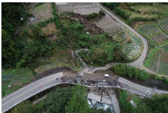
写真 4-1：地すべり全景写真(2019 年 10 月 16 日撮影)
