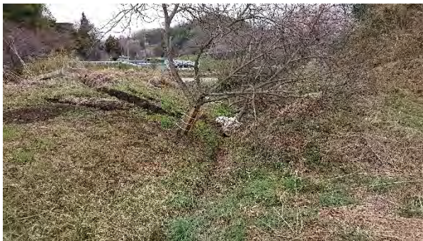
写真 1-4：地すべり地内の斜面の山側への傾動
