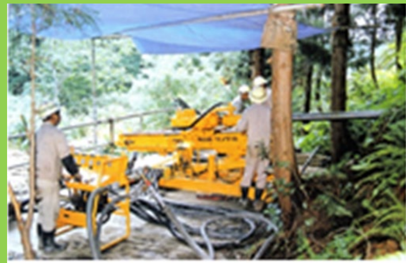
地表集水ボーリング工
