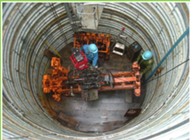
井筒内集水ボーリング工
