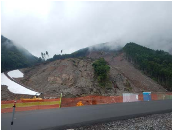
写真-5 対策工事状況 (H30. 6 撮影)
