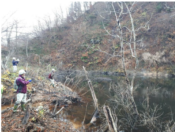
写真5 末端部に形成された土砂ダム
