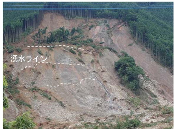
写真-2 崩壊斜面からの湧水状況（7/8 撮影）
