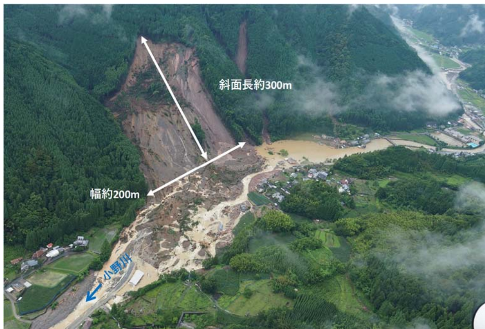
写真-1 崩壊地の全景
