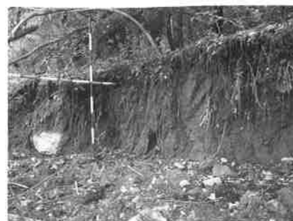
写真-7 主体ブロック右側壁
