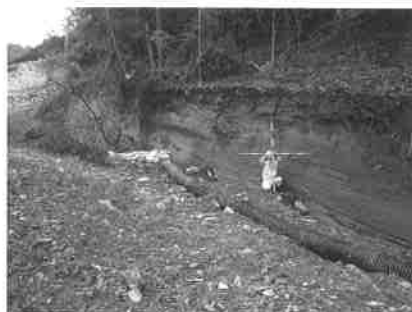
写真-6 主体ブロック左側壁の擦痕
