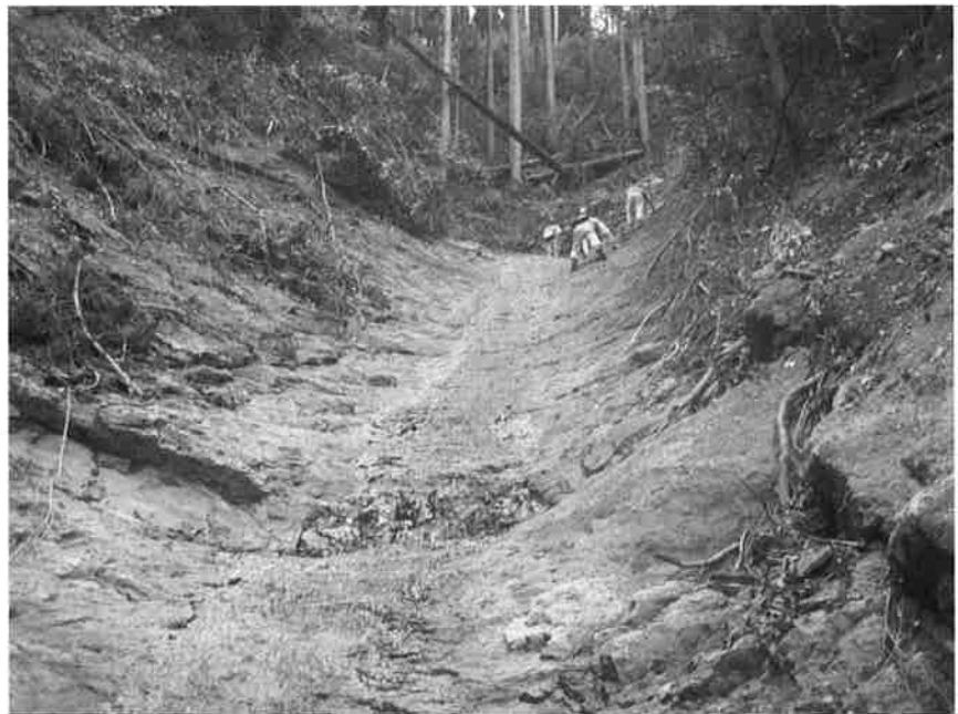
写真-3 土石流の源頭部となった小沢（岩溝状の流下痕）
