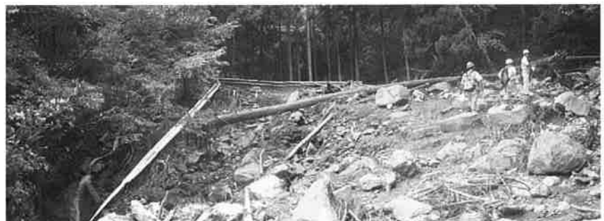
写真-4 沢の出口を林道が横切る箇所（土石流が扇状型に広がった）
