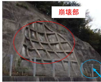
現在のモルタル吹付斜面の状況
