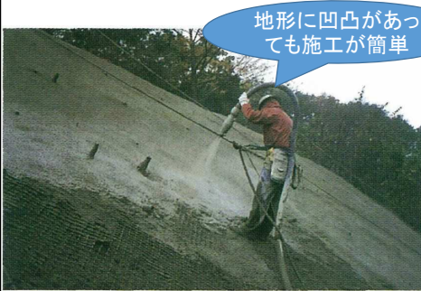
モルタル吹付施工状況 (高速道路技術センター:現場のチェックポイント,平成11年3月より引用)
