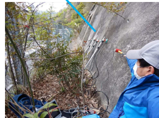
一次元表面波探査実施状況
