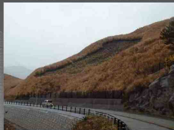
対象地(崩壊斜面)の状況 崩壊規模: 幅約25m, 長さ約50m, 深さ約1m (崩壊前の斜面勾配約34°)
