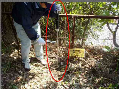
土層強度検査棒による c, \phi 測定状況
