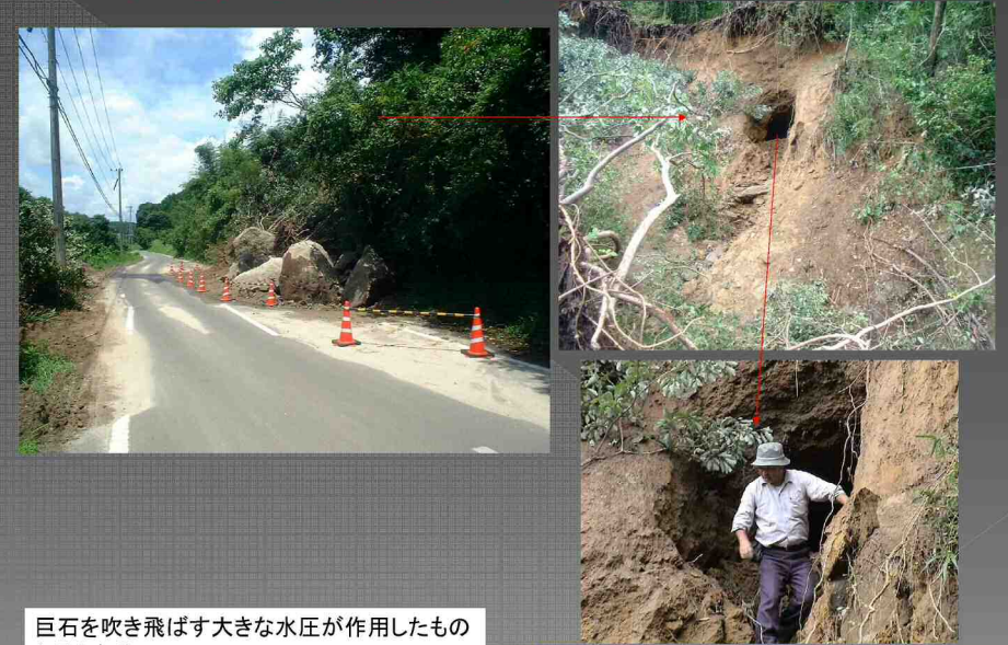
パイプ流の被圧水圧で爆裂した巨大な穴
