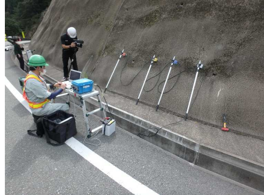
モルタル吹付斜面の表面波探査
