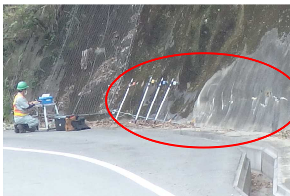
B. モルタル吹付にひび割れが生じている斜面
