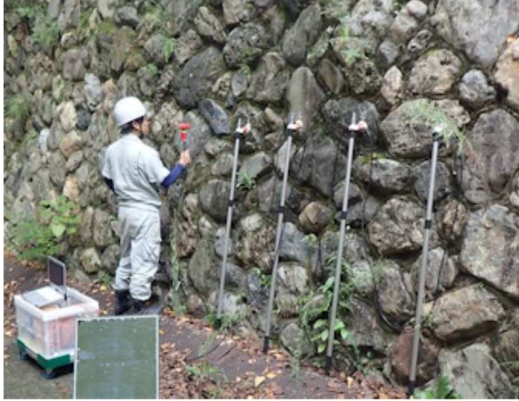
擁壁の表面波探査
