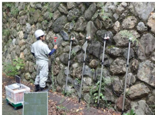
擁壁の表面波探査状況
