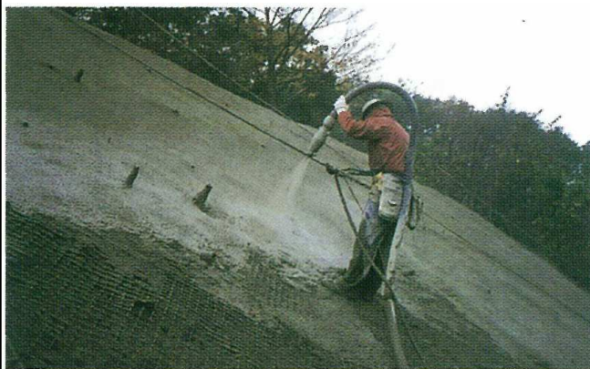
モルタル吹付施工状況
