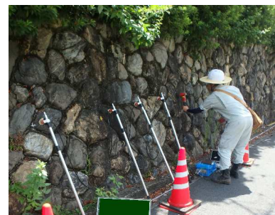
図-1 空石積擁壁の表面波探査状況
