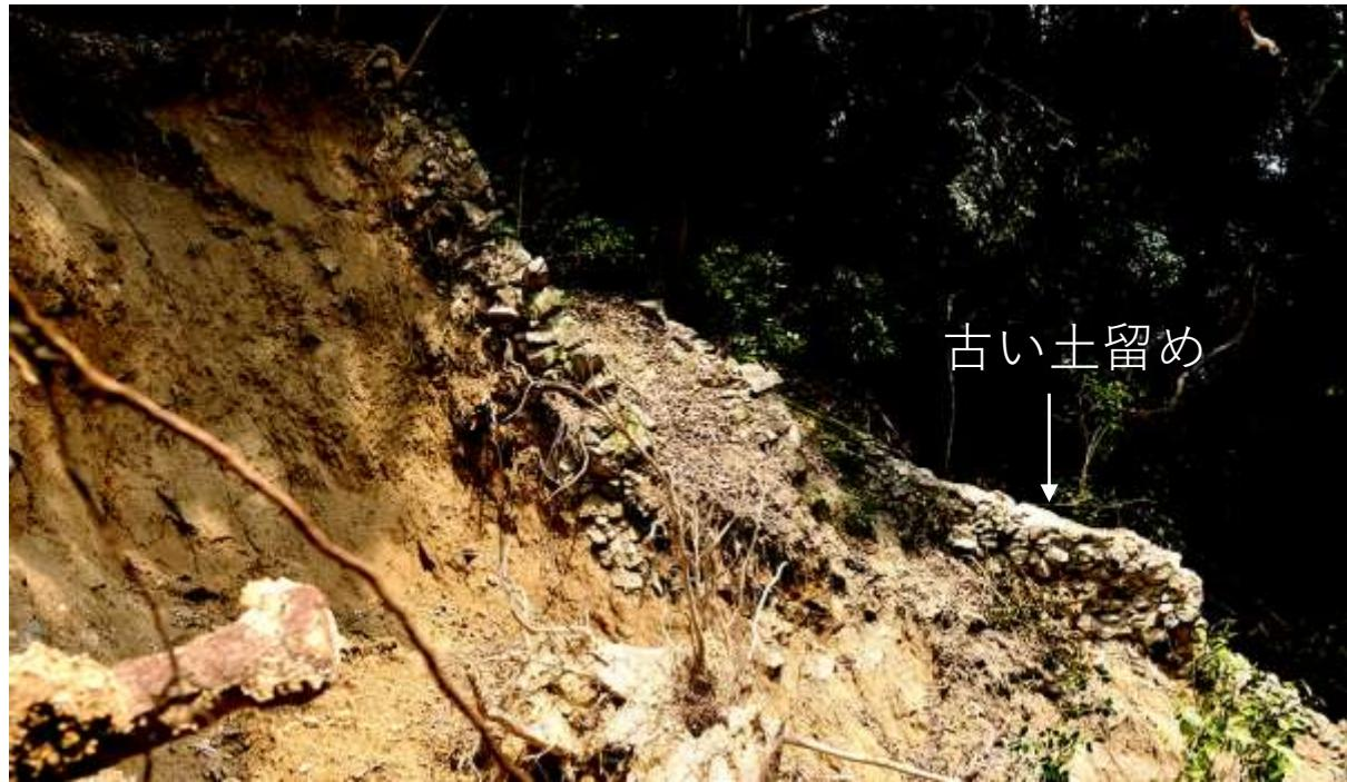
崩壊地の末端には、古い土砂留めと堰堤（おそらく、私設）があったが、今回の崩壊で破壊された。もともと斜面安定の問題を抱えていたのかも知れない。
