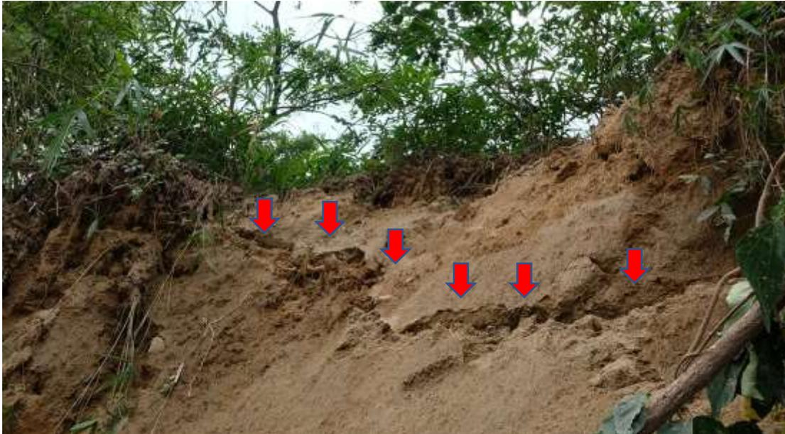
滑落崖の浅い部分に、地下水の噴出孔（パイプ）が連続して帯状の窪みが出来ている。
