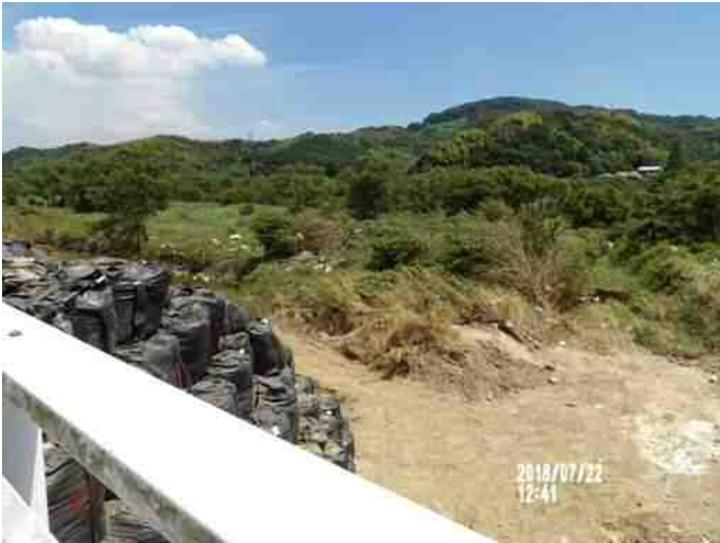
写真-1 地点1の小田川破堤地点から小田川の河道を見る（7月22日筆者撮影）
