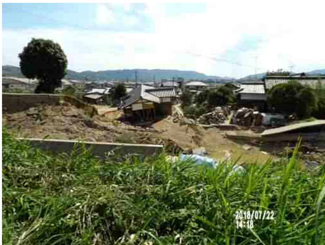
写真－8 調査地点7の末政川左岸から見た右岸の被災状況(筆者撮影)
