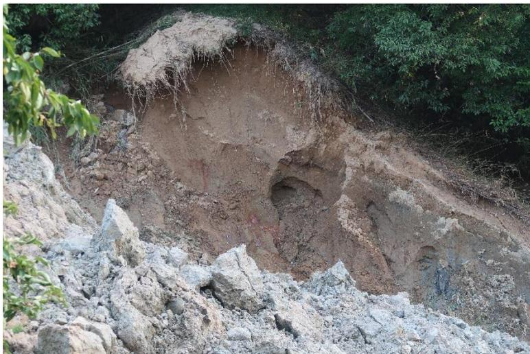
写真8：下流のため池堤体（左側）における大きな破壊により露出した堤体の内部構造
