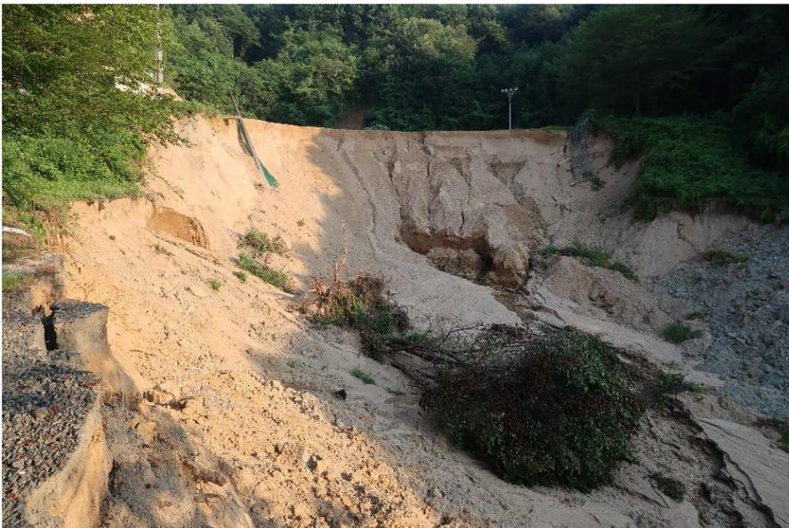
写真4：グラウンドの下流側から見た様子を示す。末端から湧水が出ている。
