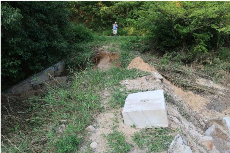
写真7：下流のため池堤体（右側）における小さい破壊
