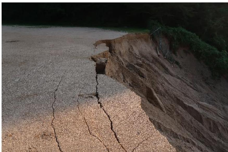
写真5：グラウンドの表面に形成された開口クラック
