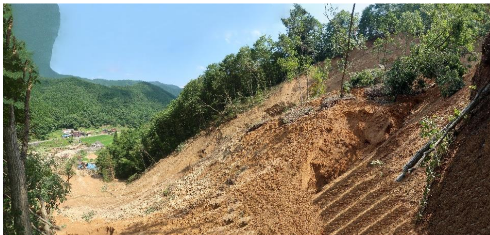
写真 2：源頭部に堆積している崩土
