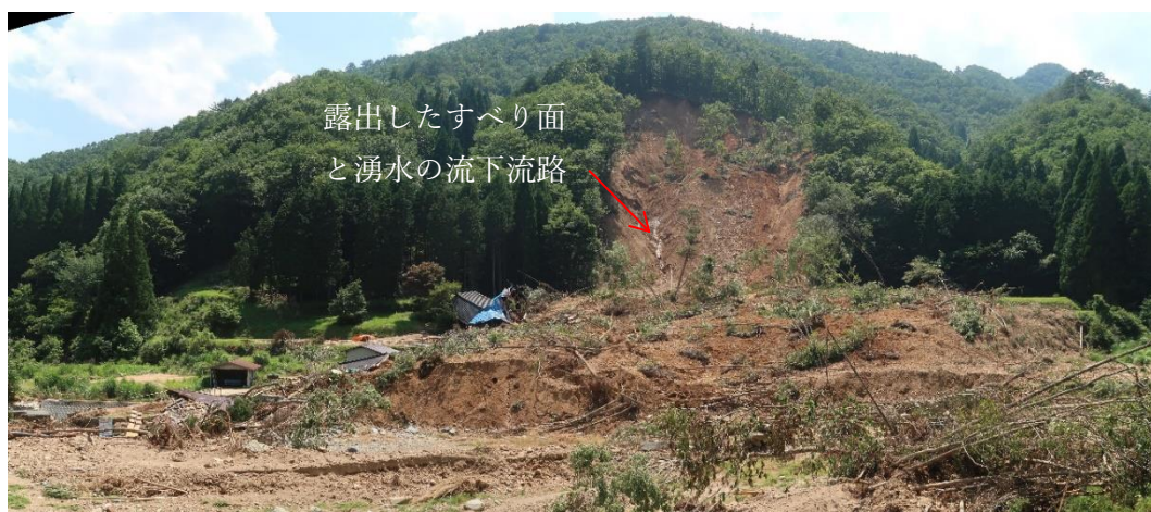
写真 1：宍粟市一宮町公文地区の斜面崩壊（2018 年 7 月 14 日撮影）
