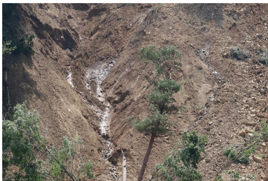
写真 3：露出した花崗岩および崩土の様子
