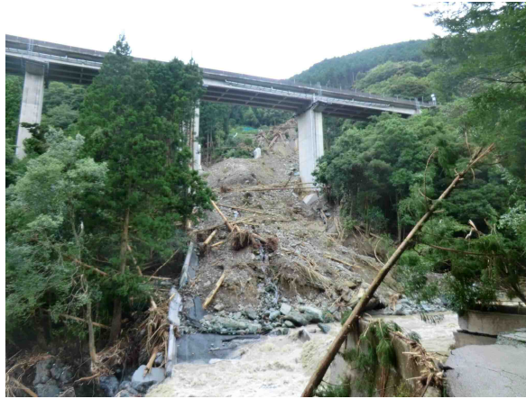
写真1 真下から被災区間を見上げる
