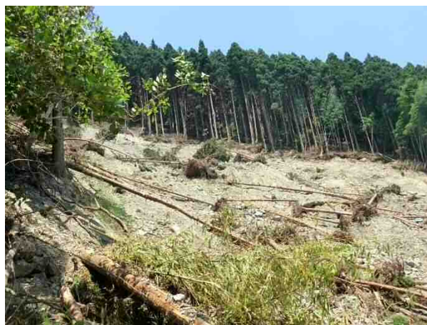
写真 8 地点④より崩壊上部を見る
