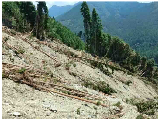
写真 7 地点④より崩壊の対岸を見る
